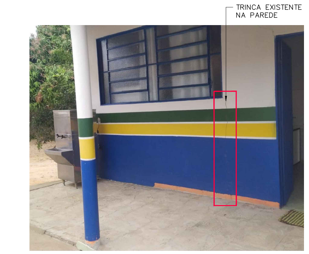
8 FOTO 01 - DETALHE TRINCA NA PAREDE S/ESCALA
